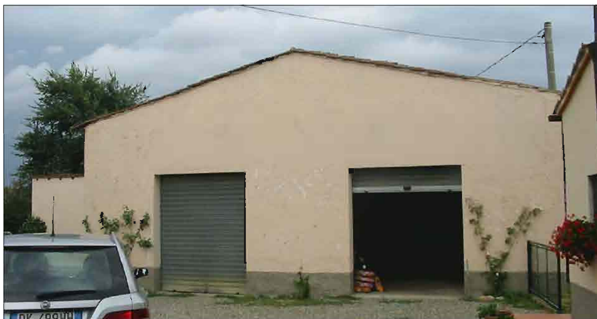
Foto prospetto Sud-Ovest
